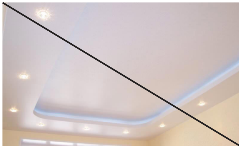
Плохо Многоуровневые гипсокартонные конструкции
